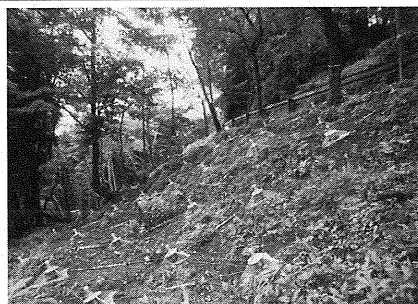
ノンフレーム工法の施工例
